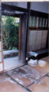
▶雨漏りによって壁が腐りかけている。
